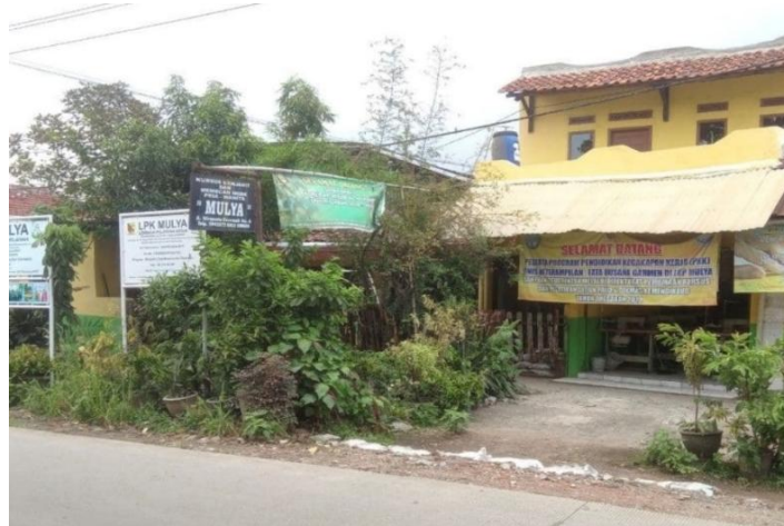
Gambar 1. Bangunan LKP Mulya
